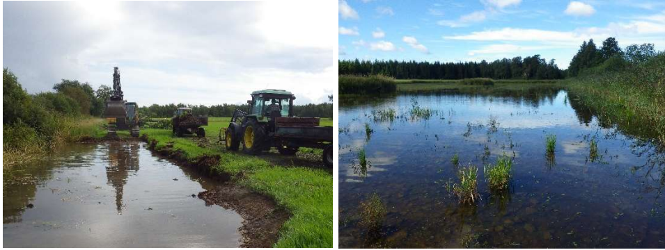
Figur 14. Del av Kissviks myr i Bångån på Gotland där schaktning av mark motsvarande ca 1 ha i direkt anslutning till Bångån genomfördes för att skapa en grund vattenmiljö lämplig för gäddlek och för att höja omgivande mark. Foton: Lars Vallin
